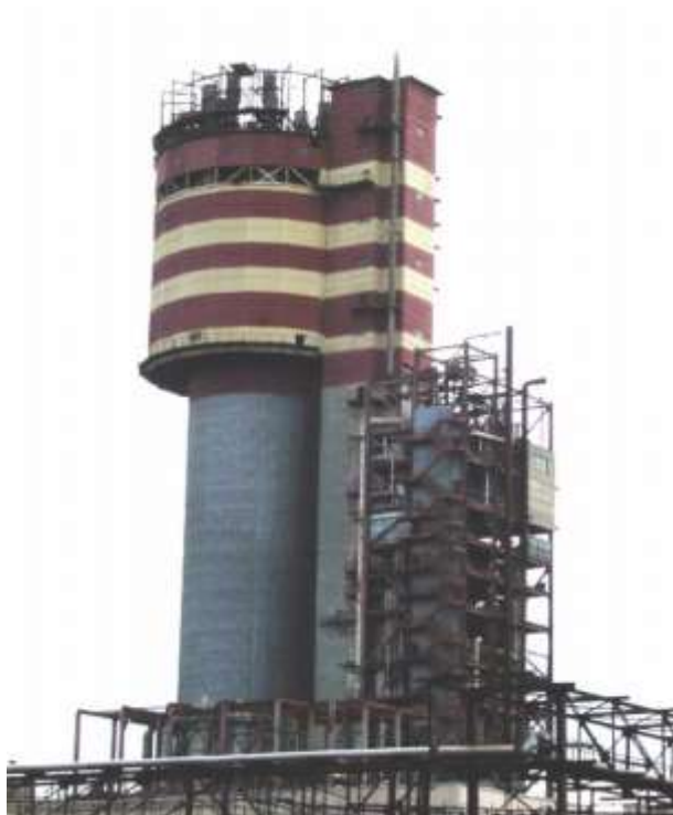
Рисунок 8.13 — Башня прилирования с железобетонным стволом
