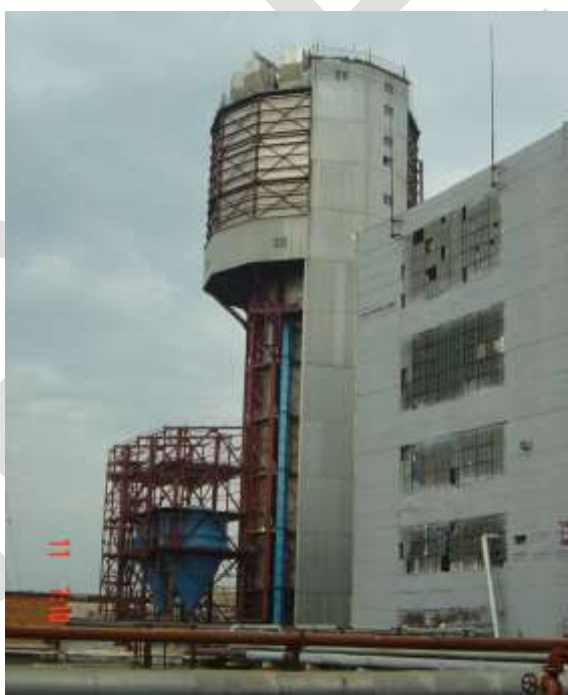
Рисунок 8.14 — Башня прилирования с металлическим стволом
