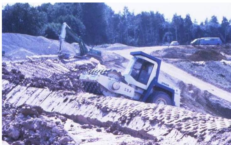
Рисунок 2.2 – Уплотнение глиняного экрана [26]
