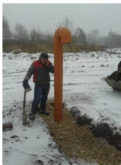
Рисунок 2.14 – Газовыпуск при устройстве траншейной системы сбора биогаза (Пермский край) [46]
