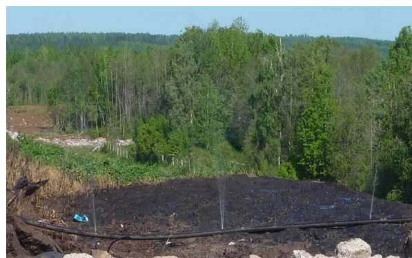
Рисунок 2.18 – Распыление фильтрационных вод на поверхности ОРО [55] (ОРО ТКО в Пермском крае)
