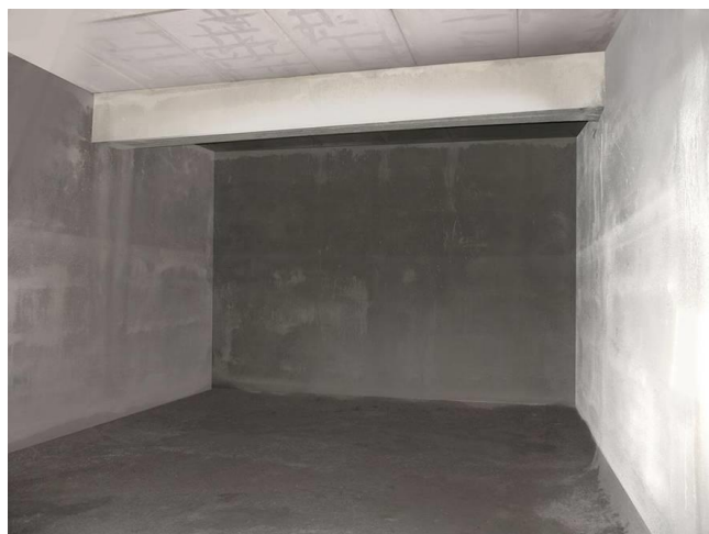
Рисунок 2.6 – Бункер для захоронения отходов в Ставропольском крае. Вид изнутри [30]
