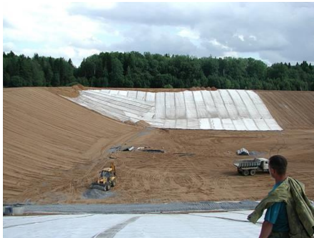
Рисунок 2.4 – Устройство ПФЭ из полимерной геомембраны на ОРО в Московской области [26]
